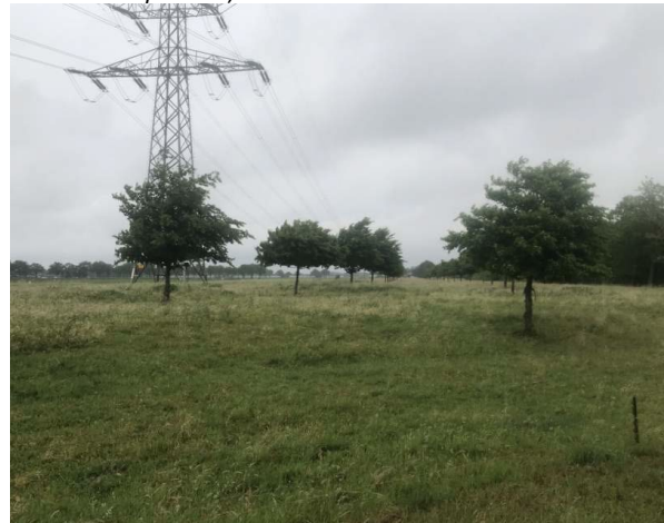
Figuur 10: Detail NNB (N15.02) ter hoogte van deelgebied 21. Er zijn enkele bomen aangeplant, en verder bestaat het gebied uit extensief gemaaid grasland. Hier zijn hoogspanningsleidingen en ligt een leidingstraat in de grond.
