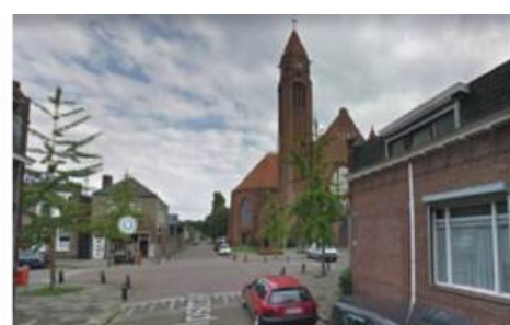
Zicht vanuit Tulpstraat (noordwest)
