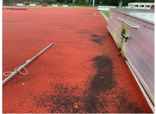
afb.2: slijtage coating afzet hoogspringen
