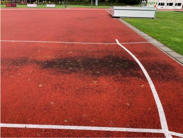
afb.1: slijtage coating afzet speerwerpen
