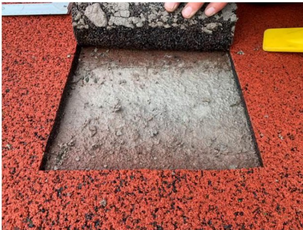
afb.3: permeabel celbeton zacht / verpapt
