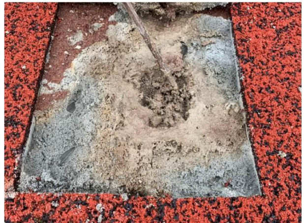
afb. 4: permeabel celbeton zacht / verpapt
