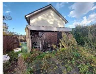
Figuur 2.5 Schuur aan noordzijde van de onderzoekslocatie.
