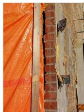
Figuur 5.5 Zichtbare ruimte tussen de zuidelijke gevel en de spouwmuur aan de Genestetlaan 14.
