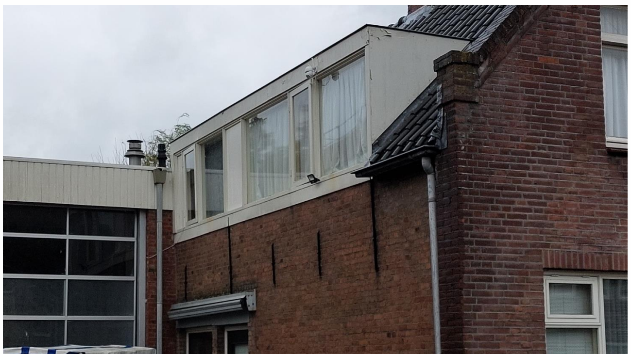
Figuur 4.4.2. De zuidgevel van de woning.
