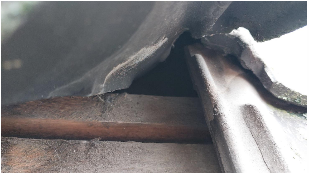
Figuur 4.4.1 Onder de onderste rij dakpannen is geen vogelschroot aanwezig; de ruimtes onder de onderste dakpannen zijn daarom geïnspecteerd maar vogelnesten zijn afwezig.
