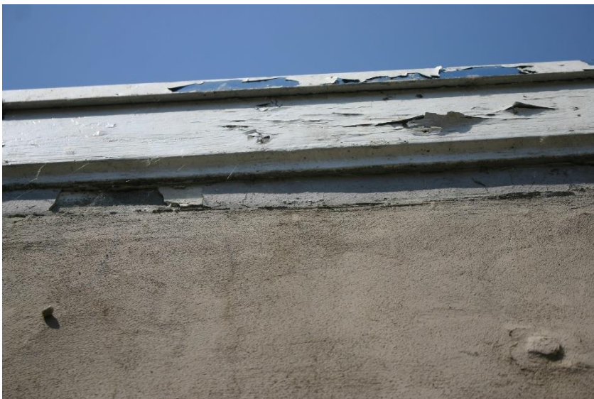
Figuur 4.4.2. De dakranden bevatten geen openingen waar vogels of vleermuizen door naar binnen kunnen.
