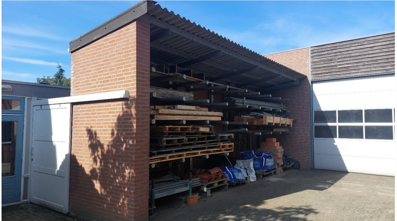
Figuur 4.4.2. De opslagoverkapping is geheel enkelwandig.
