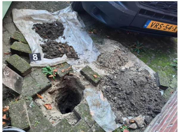
Asbestinspectiegat 8
