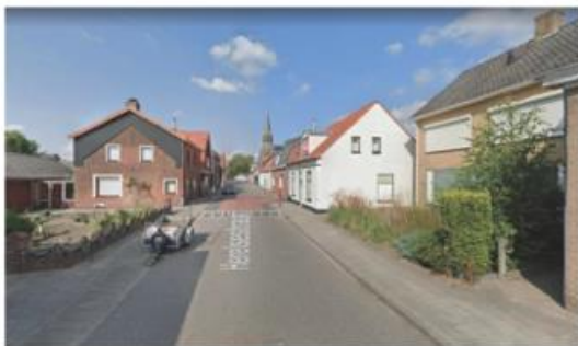
Herelsestraat, plaatselijk terugspringende rooilijn
