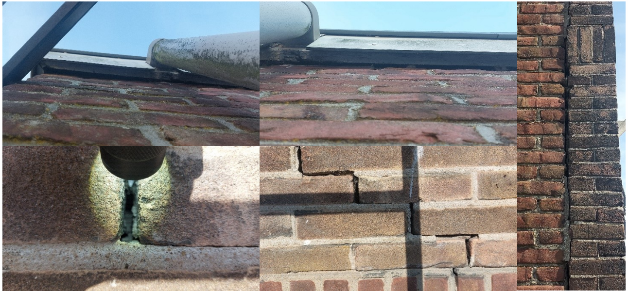
Figuur 4.4.4. Kieren tussen de gevels en het boeiboord (boven) en gaten/spleten in de gevels (onder en rechts) van de woningen.
