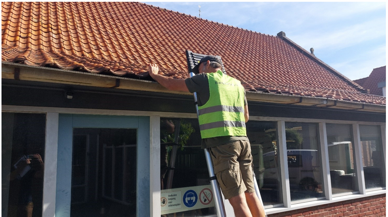
Figuur 4.4.3. De ruimtes onder de dakpannen zijn geïnspecteerd; vogelnesten zijn afwezig.
