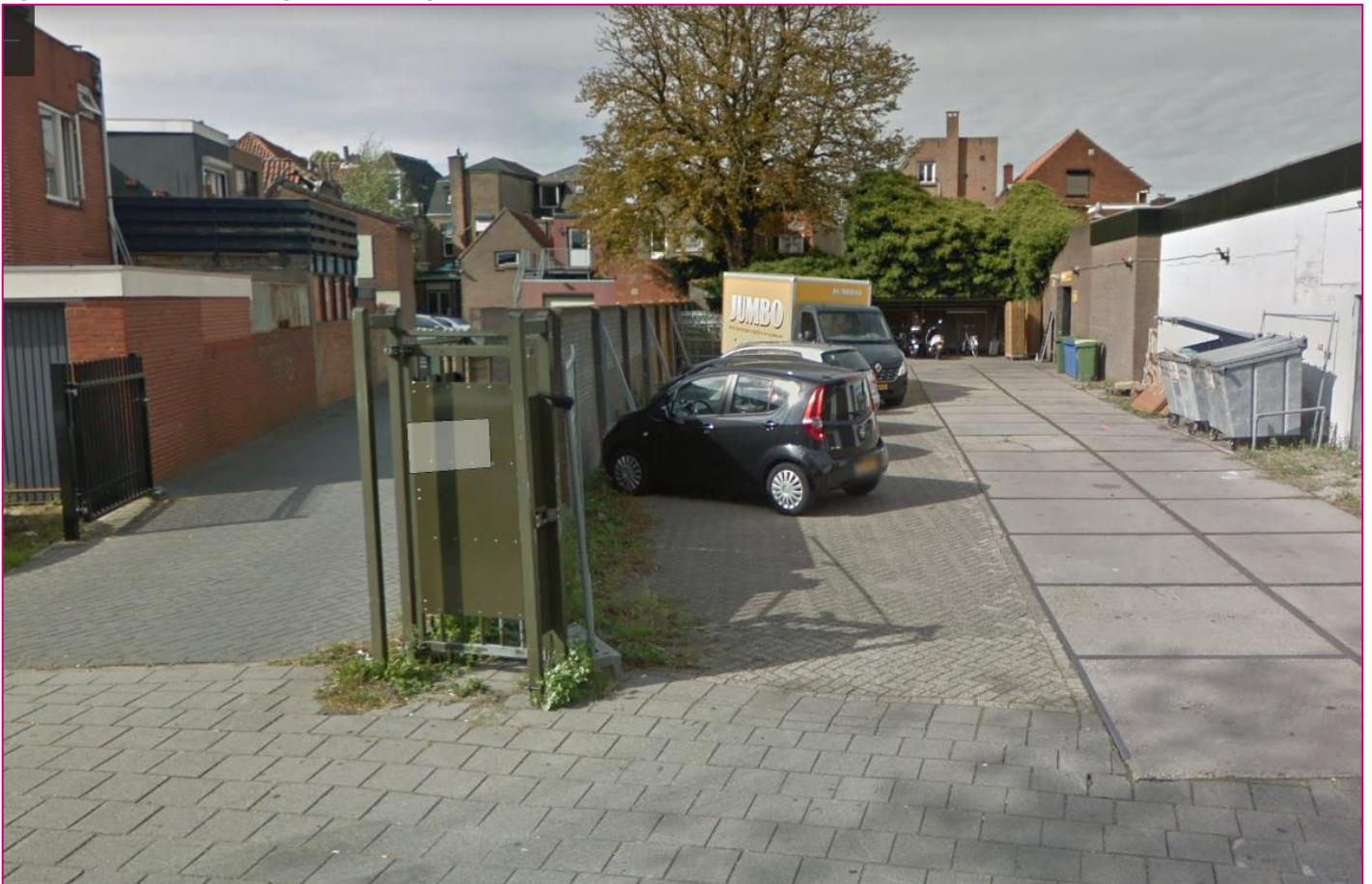
Figuur 6.1: situatie achtergevels woningen Boulevard
