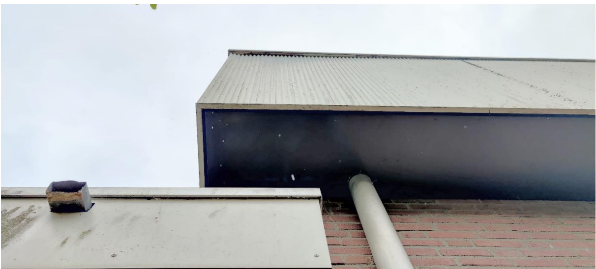
de ruimte tussen de gevelbetimmering kan vleermuisverblijven herbergen
