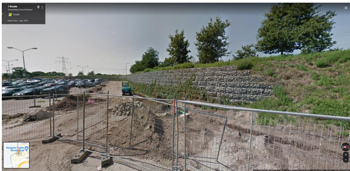
Afbeelding 4 Uitsnede van GoogleStreetview ter hoogte van de keerwand in het zuidelijke deel van het plangebied. Bron: Google.
