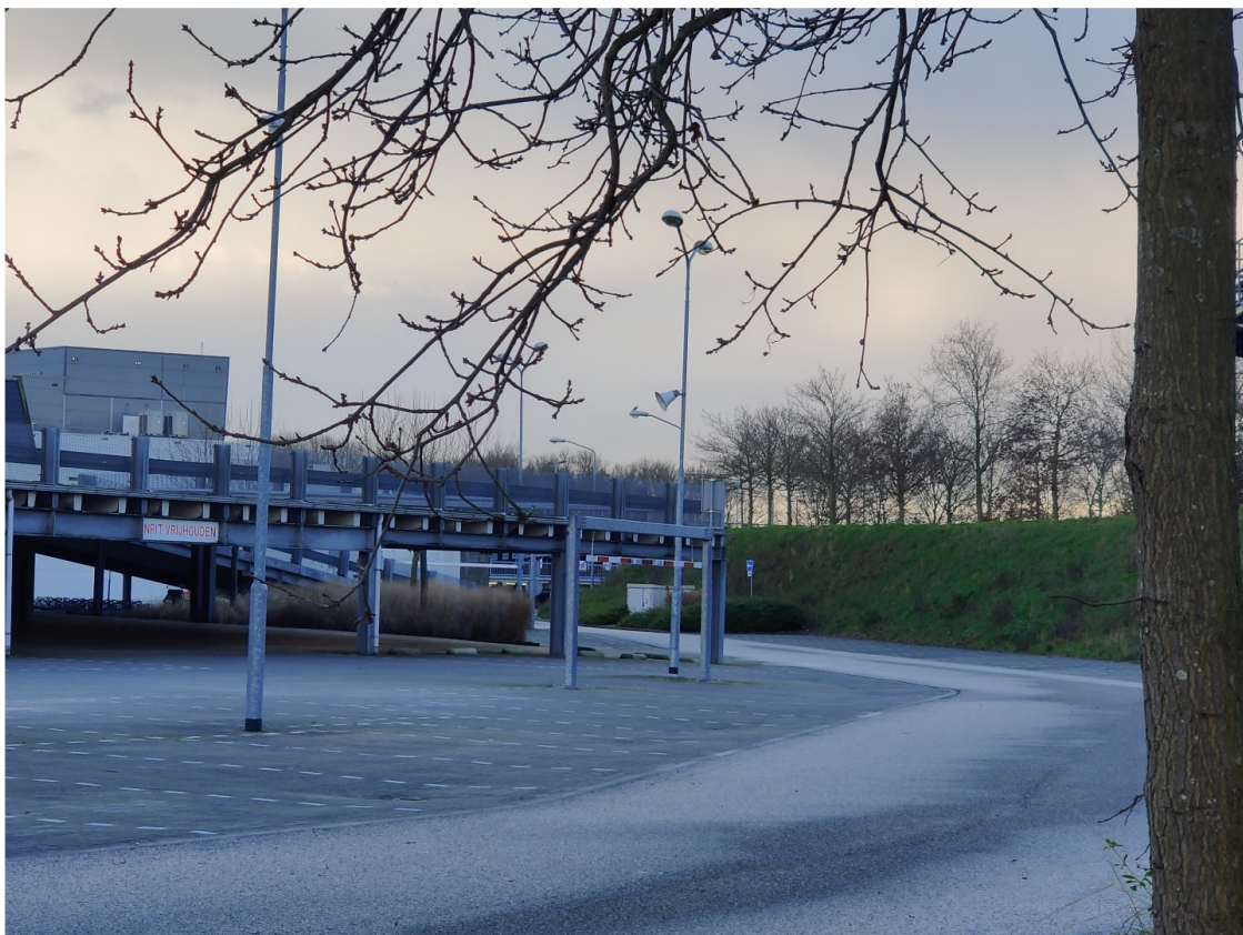
Beide foto's geven zicht op het parkeerdek in het noordelijk deel van het plangebied.
