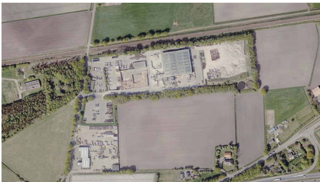
Figuur 4: Luchtfoto terrein (Bron: Streetsmart)
