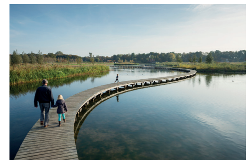
Aanleggen wandelroute rondom De Dassenplas (rondje Dassenplas)
