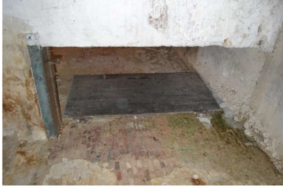
Oorspronkelijke binnenwandopening met deur naar de voormalige machinekamer.
