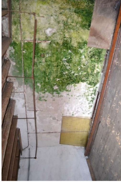
Later geplaatste binnenwand/gevel.
