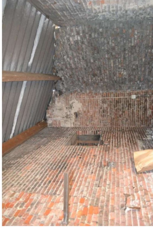
Zicht op afgesneden hoek met links de oorspronkelijke binnenwand tussen vm. olieslagerij en bergplaats.
