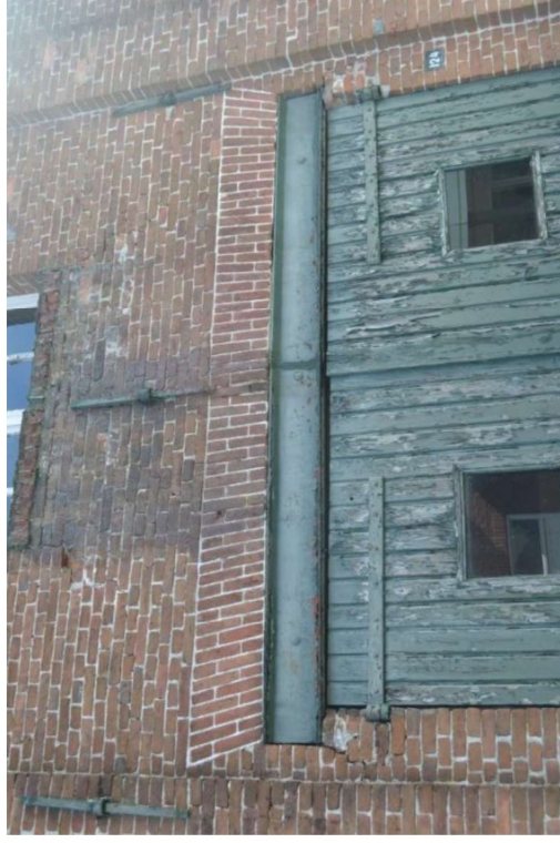
Dubbele houten deur met stalen latei en gemetselde hanenkam.
