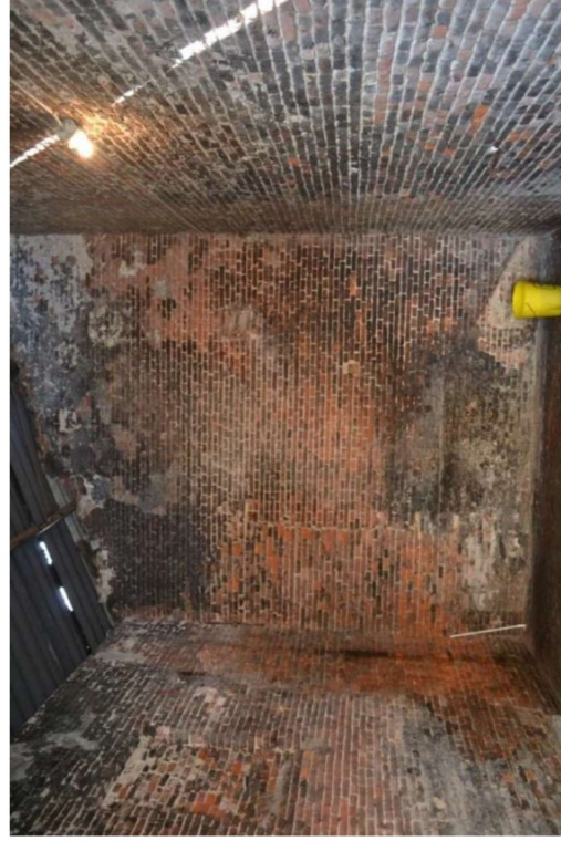
Oorspronkelijke binnenwand met links in het metselwerk zichtbaar de gesloopte kastwanden.
