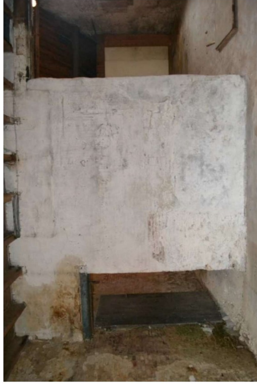
Deel van de oorspronkelijke binnenwand tussen voormalige maalderij en voormalige machinekamer, met links de oorspronkelijke binnenwandopening.
