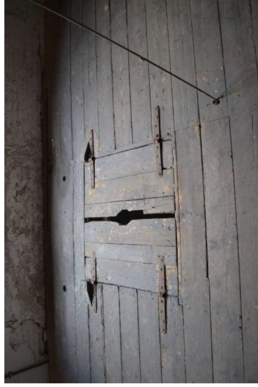
Houten luik in verdiepingsvloer t.b.v. laden en lossen van goederen.
