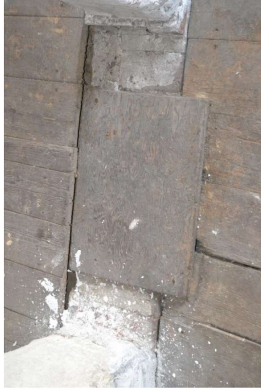
Later aangebrachte doorbraak in tussenmuur.
