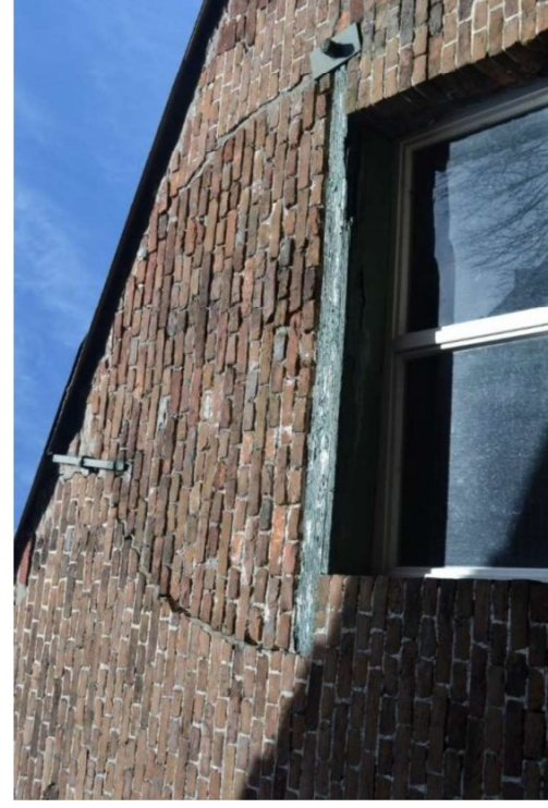
Dichtgemetselde cirkelboog boven later aangebracht kozijn.
