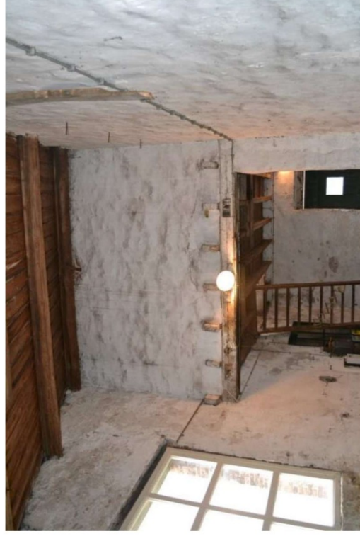
Zicht op oorspronkelijke binnenwand tussen voormalige maalderij en voormalige machinekamer, thans voorzien van opening onder een dubbele houten latei.
