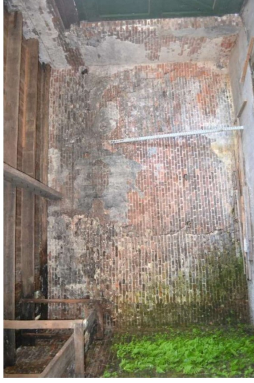
Oorspronkelijke binnenwand tussen olieslagerij en maalderij (met links de dichtgemetselde opening).
