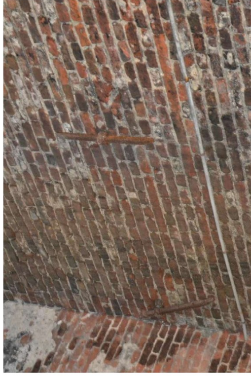
Gevelankers ten behoeve van verdiepingsvloer.
