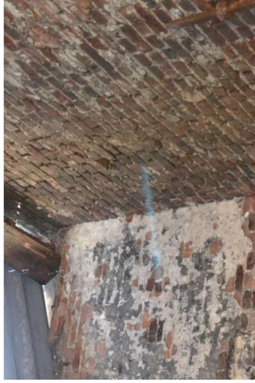
Aansluiting oorspronkelijke binnenwand met later geplaatste wand.
