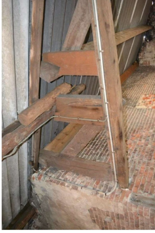
Later geplaatste houten kapconstructie tegen oorspronkelijke binnenwand.
