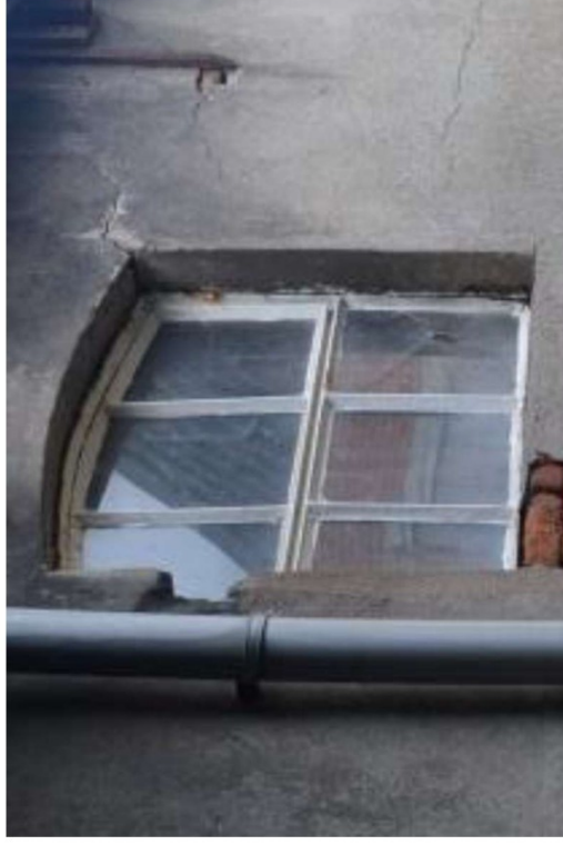
Stalen raam met kiepraam.
