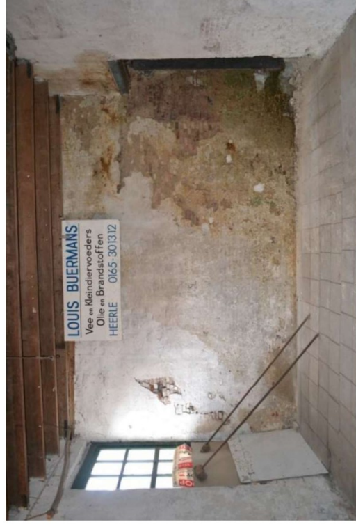
Oorspronkelijke binnenwand tussen voormalige maalderij en voormalige olieslagerij.
