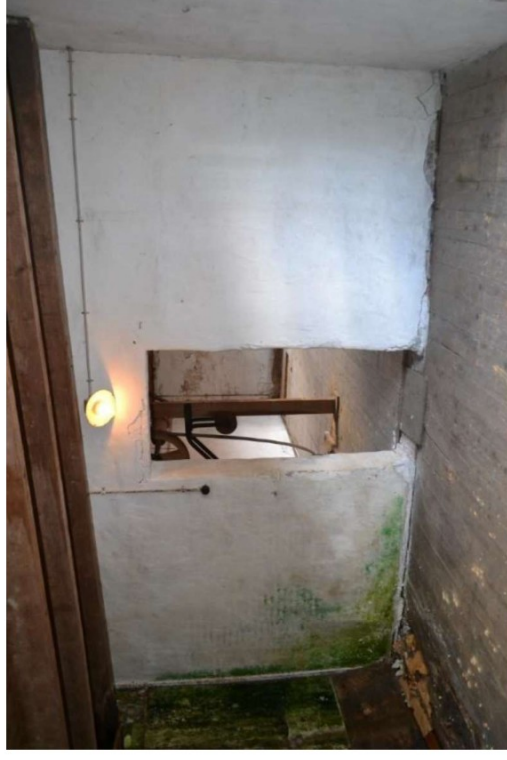
Oorspronkelijke binnenwand met later aangebrachte doorbraak.
