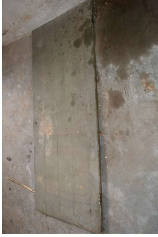
Aanwezig put, afgedekt met een houten 'luik' (deur).
