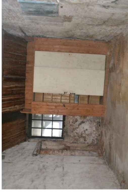
Later geplaatste kastenwand in machinekamer.
