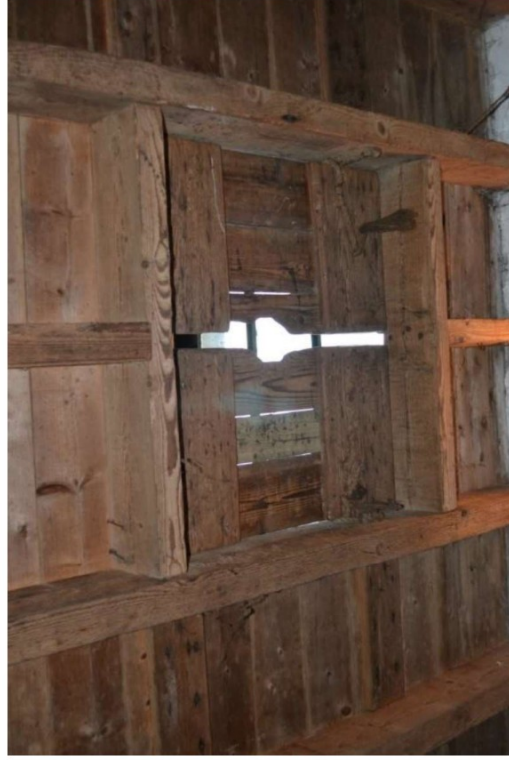
Houten luik in verdiepingsvloer ten behoeve van laden en lossen van goederen.
