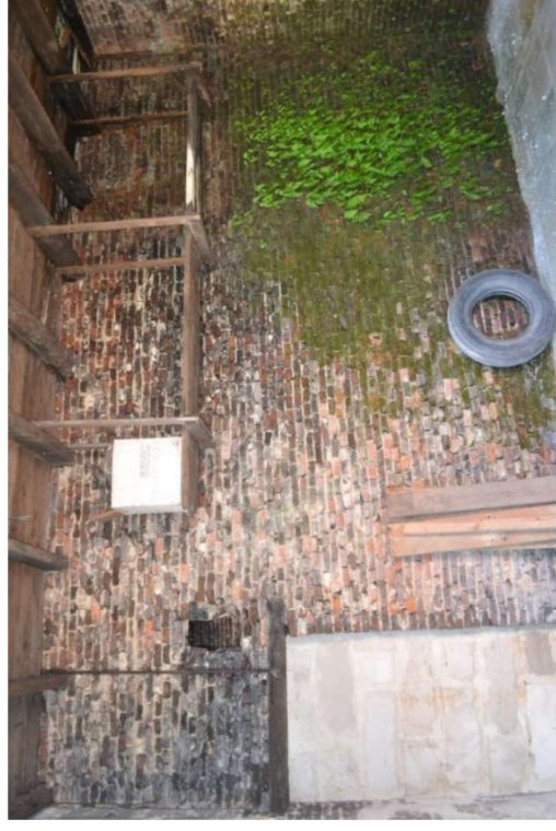
Later geplaatste binnenwand in vm. olieslagerij (met links een dichtgezette opening).
