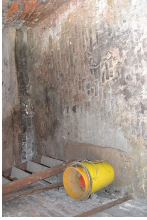
Vloer van gebakken klinkers, mogelijk uit de bouwtijd.
