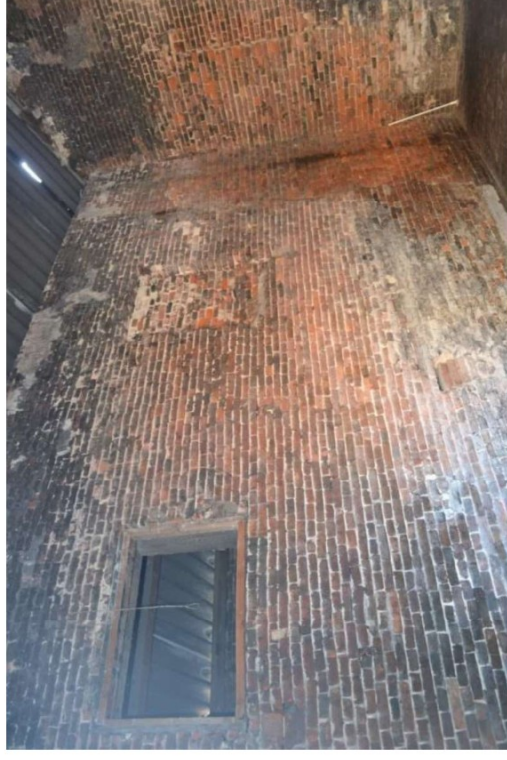
Oorspronkelijke achterzijde voormalige olieslagerij.
