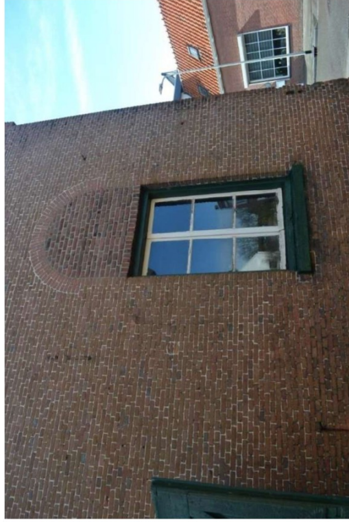
Houten venster met dichtgezet bovendeel onder cirkelboog.
