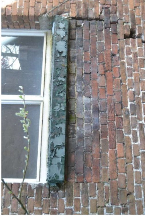
Inboetwerk onder kozijn.
