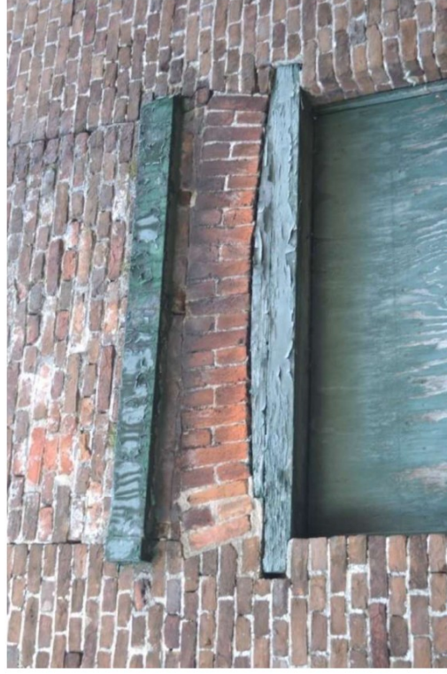
Gedeelte tussen kozijnen in linker geveldeel.
