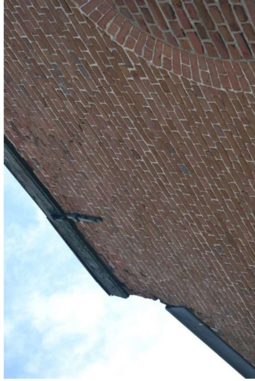
Houten boeiboord met gevelankers.
