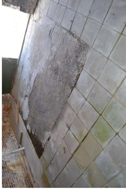
Later gelegde betontegelvloer in voormalige olieslagerij.
