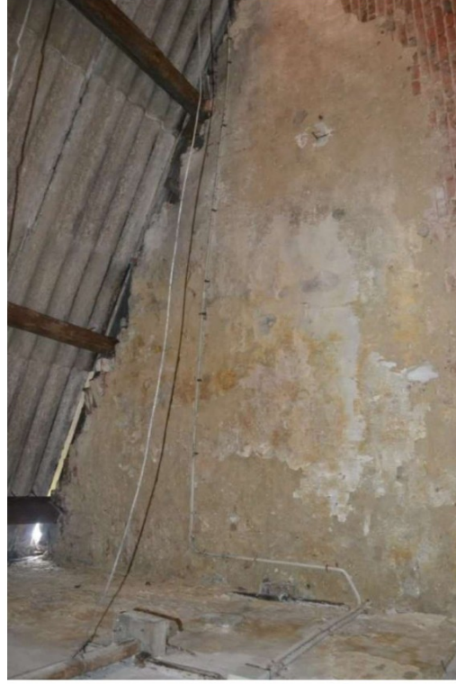
Later geplaatste tussenmuur en latere kapconstructie.
