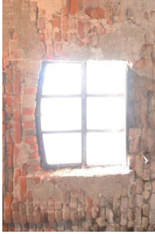
Mogelijk oorspronkelijk getoogd stalen raam met rollaag.
