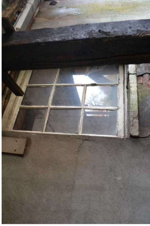
Houten kozijn met raam.
