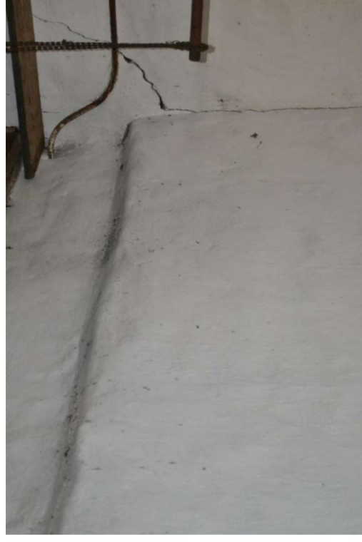
Oorspronkelijke verjonging in zijgevel waar topgevel begon.
