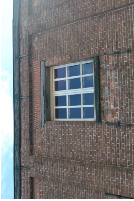
Houten kozijn met houten latei, gemetselde hanenkam en inboetwerk eronder.
