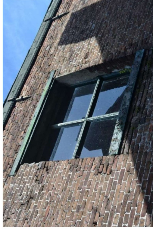
Kozijn op verdieping.
