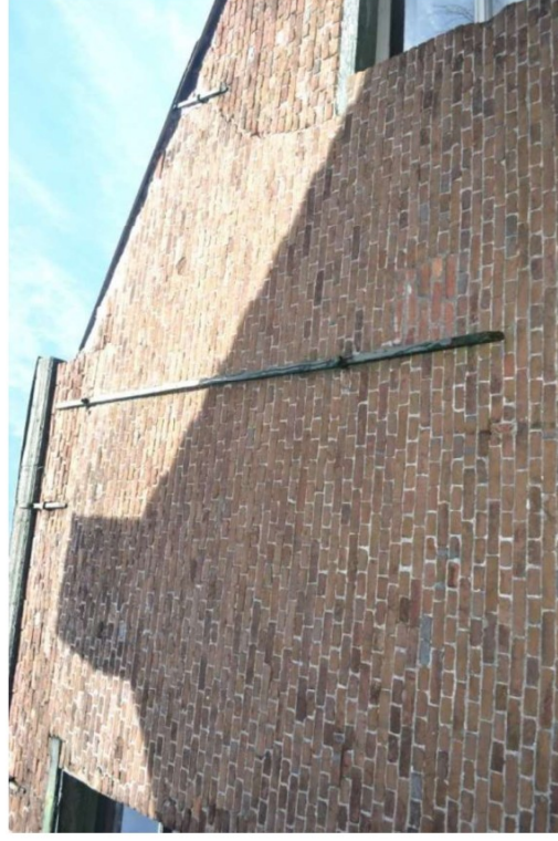
Verdiepingshoge gevelanker.
