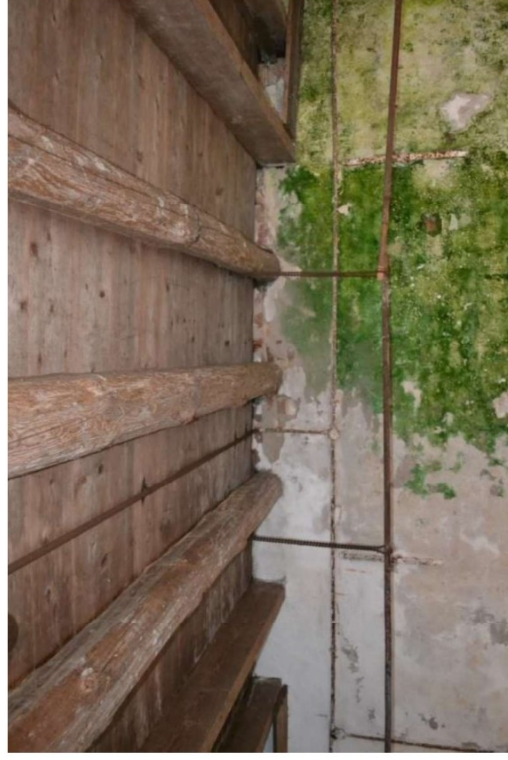
Mogelijk oorspronkelijke rondhouten balken uit de bouwtijd.
