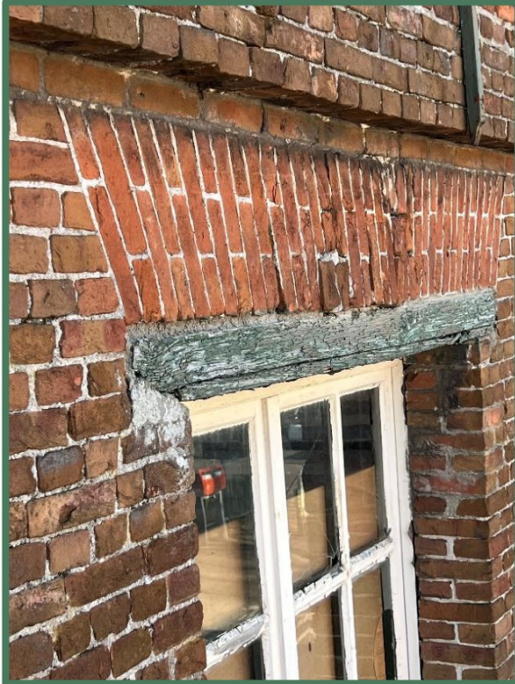
Foto 41 + 42: Ruimte tussen houten dorpel en bakstenen wand voorzien van cement.
