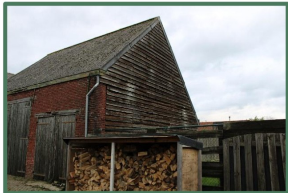
Foto 14: Oostelijke kopgevel bijgebouw, vanaf het zuidoosten.
