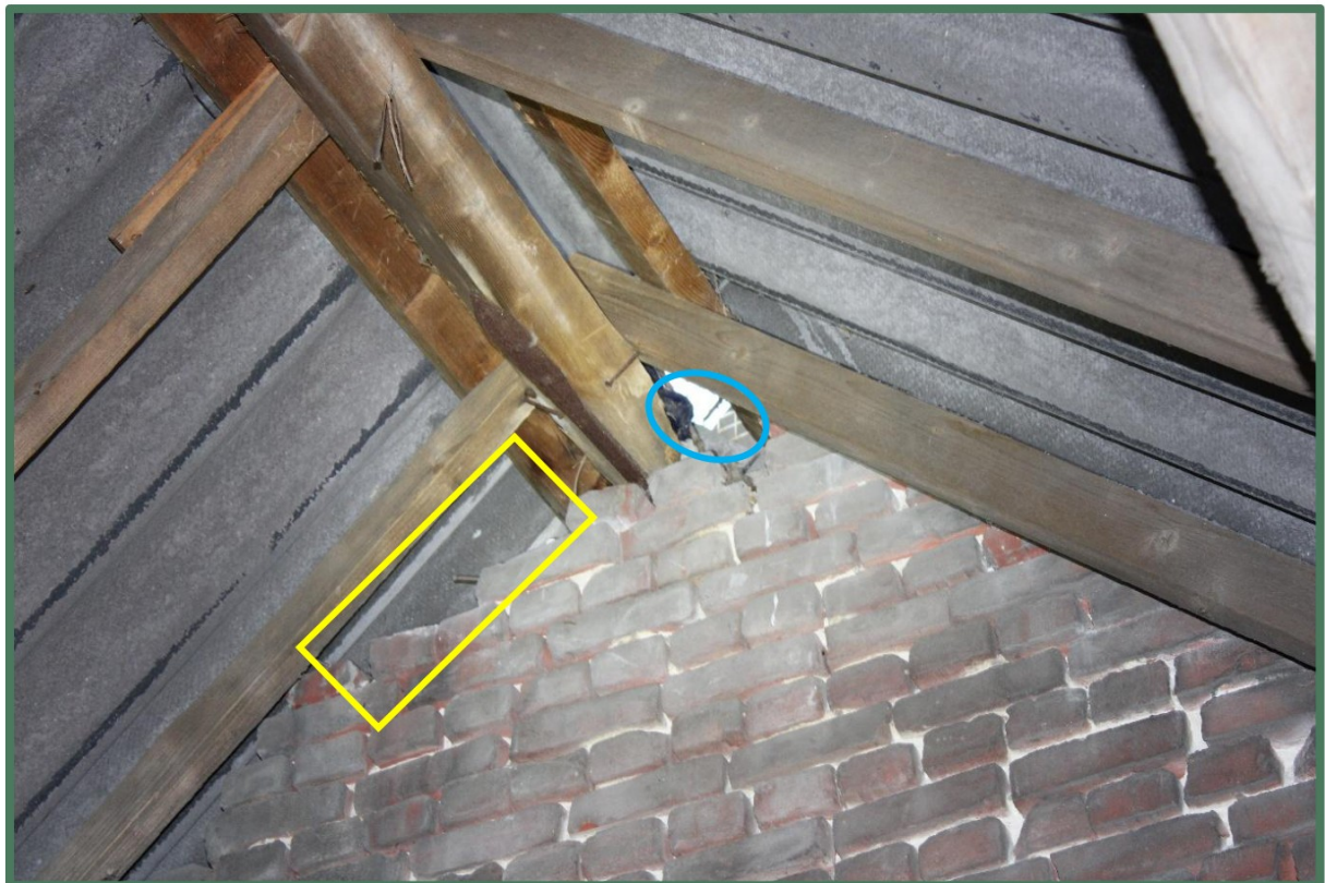
Foto 58: Nok westelijke kopgevel bijgebouw, windveer geel omlijnd, vogelschroot blauw omlijnd.
