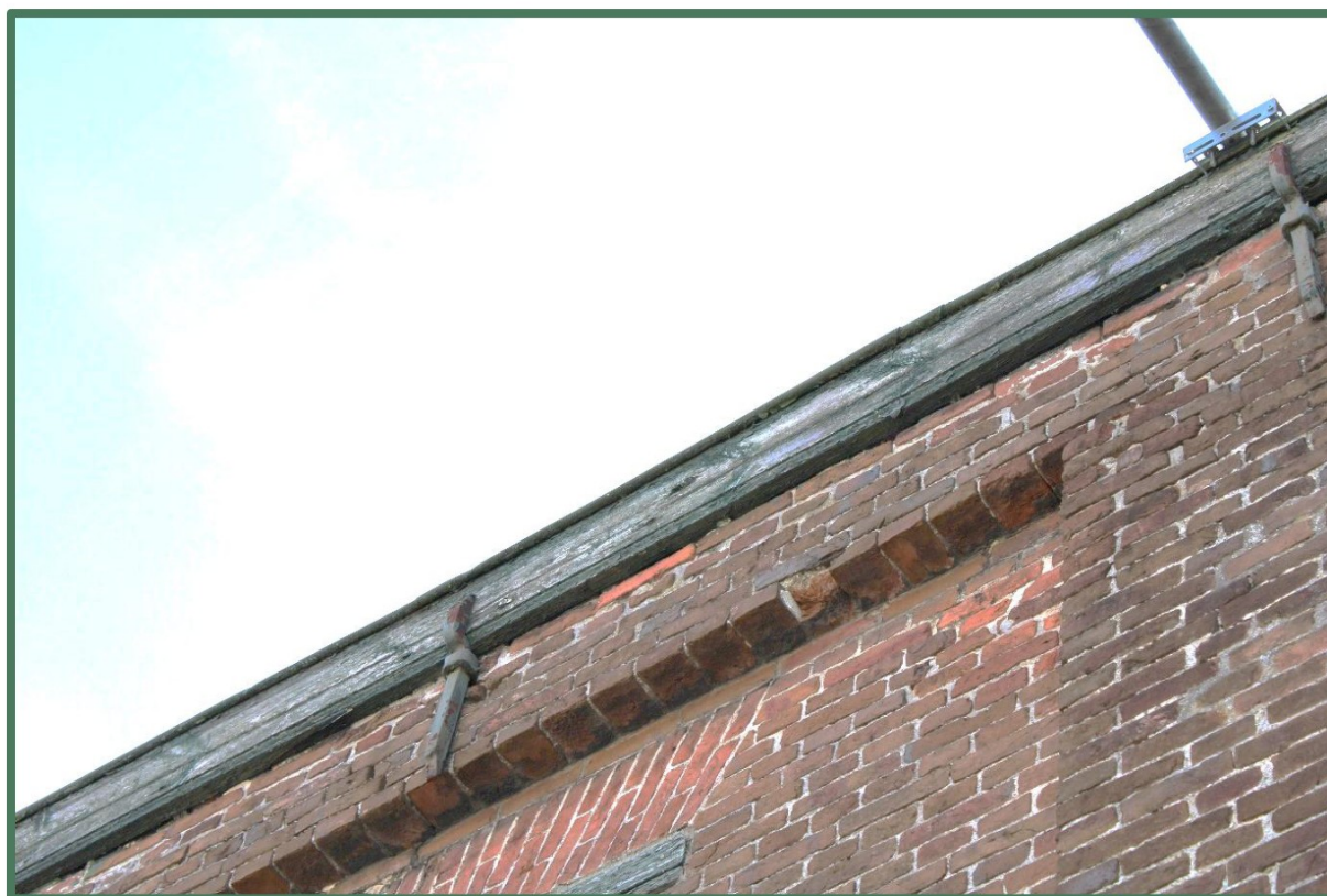
Foto 26: Strak aangesloten boeiboord bedrijfspand Herelsestraat 124.
