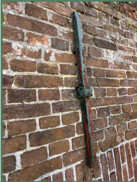
Foto 37 + 38: Ondiepe voegshade langs muuranker.
