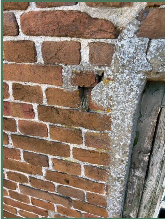
Foto 49 + 50: Ondiepe voegschade in buitengevel nr. 124, ongeschikt als verblijfplaats vleermuizen.
