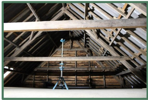
Foto 18: Eerste verdieping bijgebouw.
