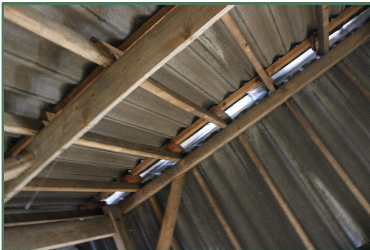
Foto 55: Kieren tussen aansluiting nok bijgebouw nr. 126, vanaf binnenzijde.
