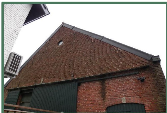
Foto 15: Westelijke kopgevel bijgebouw, vanaf het noordwesten.
