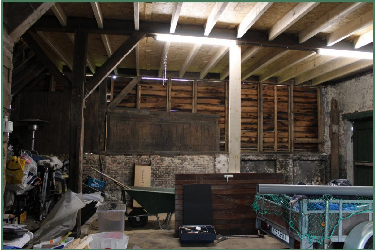
Foto 53: Kieren in oostelijke kopgevel bijgebouw nr. 126, vanaf binnenzijde.
