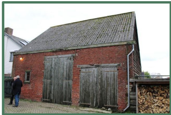
Foto 12: Zuidelijke wand bijgebouw, vanaf het zuidoosten.
