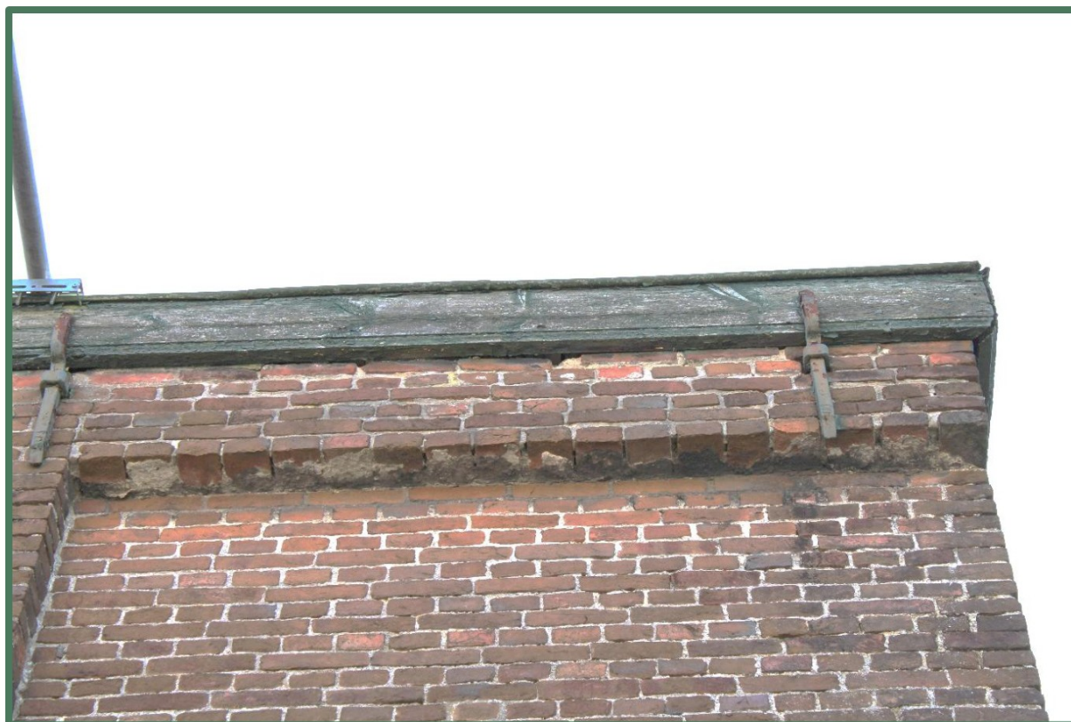
Foto 25: Strak aangesloten boeiboord bedrijfspand Herelsestraat 124.
