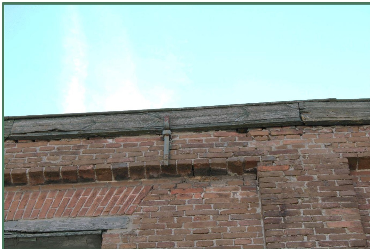
Foto 23: Strak aangesloten boeiboord bedrijfspand Herelsestraat 124.
