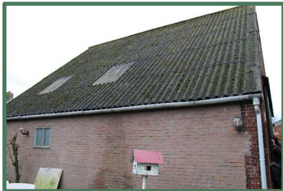
Foto 13: Noordelijke wand bijgebouw, vanaf het noordoosten.
