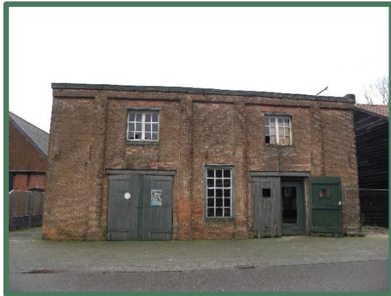
Foto 1: Westelijke wand bedrijfspand, vanaf het westen.
