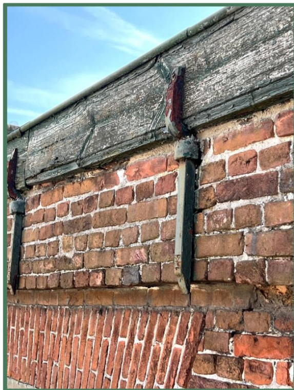
Foto 28 + 29: Strak aangesloten boeiboord bedrijfspand Herelsestraat 124.
