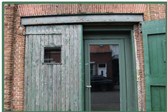
Foto 6: Dubbele deur in oostelijke wand bedrijfspand.
