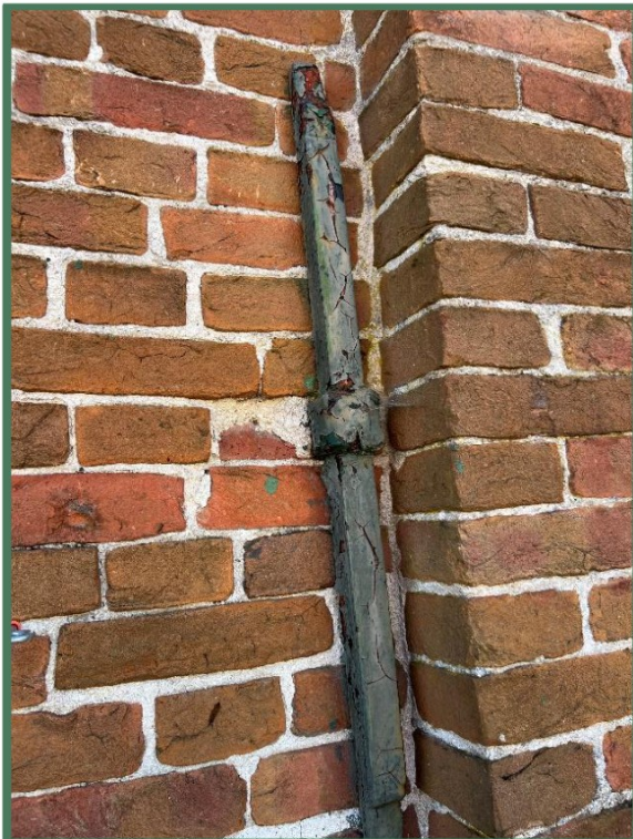
Foto 39 + 40: Ondiepe voegshade langs muuranker.
