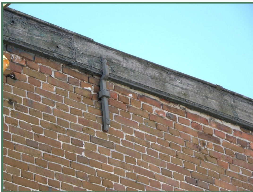
Foto 27: Strak aangesloten boeiboord bedrijfspand Herelsestraat 124.
