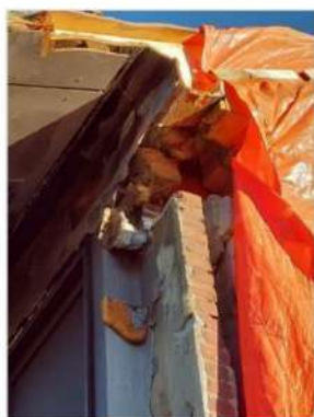
Figuur 5.3 Zichtbare ruimte tussen de gevel en het dak aan de noordwestelijk kant van de Genestetlaan 14.
