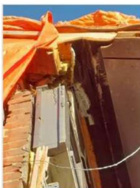
Figuur 5.4 Zichtbare ruimte tussen de gevel en het dak aan de zuidwestelijk kant van de Genestetlaan 14.
