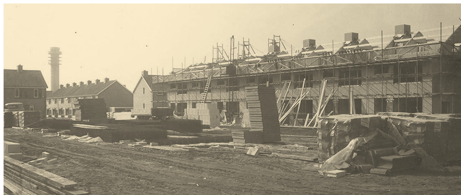
Langdonk in aanbouw (1972) - Foto West Brabants Archief
