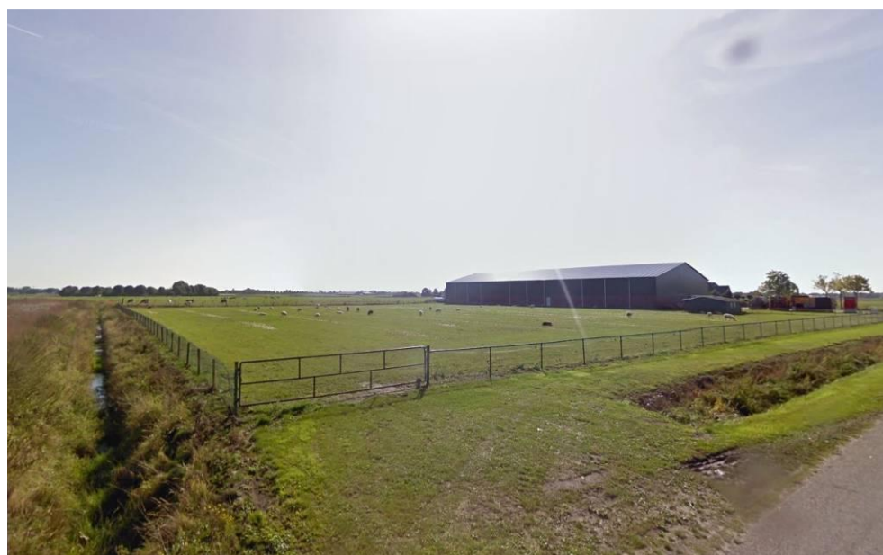
Figuur 6 - Zicht op het plangebied vanuit het noorden; de loods in het midden is de bestaande bedrijfsloods van het landbouwmechanisatiebedrijf; aansluitend daaraan zal een nieuwe loods worden gebouwd; links is de bestaande waterloop te zien; een strook van 5 m daarlangs zal worden ingericht als natuurlijke oever met bloemrijke strook; daarnaast en aan de voorkant wordt een strook met opgaand groen ter breedte van 7 m ingericht.
