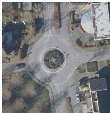
Figuur 4.12: Luchtfoto huidige situatie.
