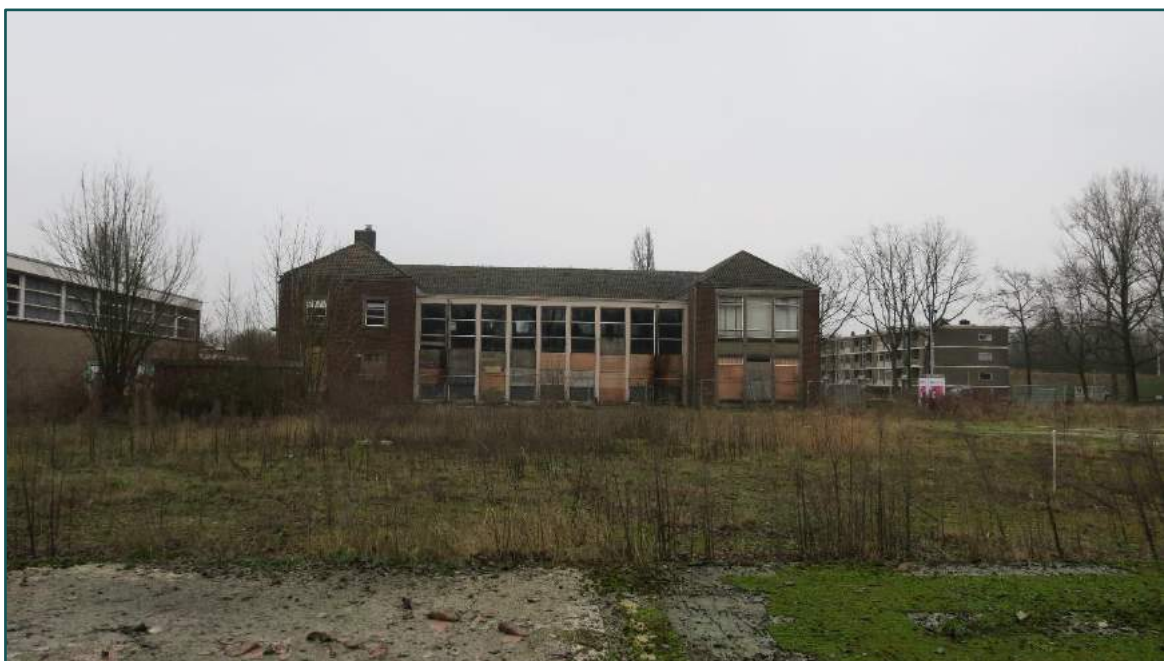
Figuur 2 Het braakliggend perceel waar de funderingen van de reeds gesloopte bebouwing nog steeds zichtbaar zijn. De bebouwing naast het braakliggend perceel wordt niet aangetast in de beoogde ontwikkeling.
