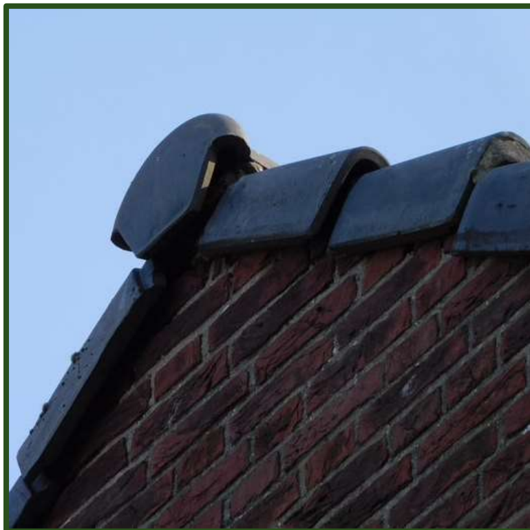
Afbeelding : Overstek van nok en de zijgevelpannen
