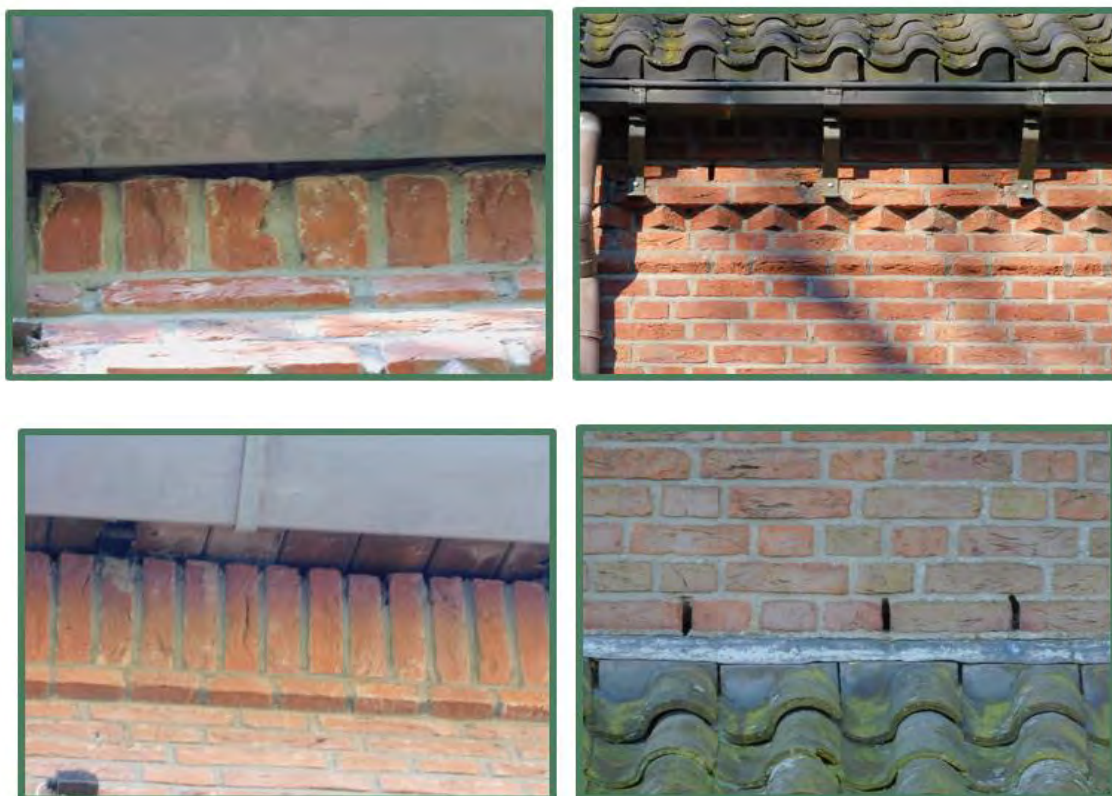
Mogelijke verblijfplaatsen vleermuizen
