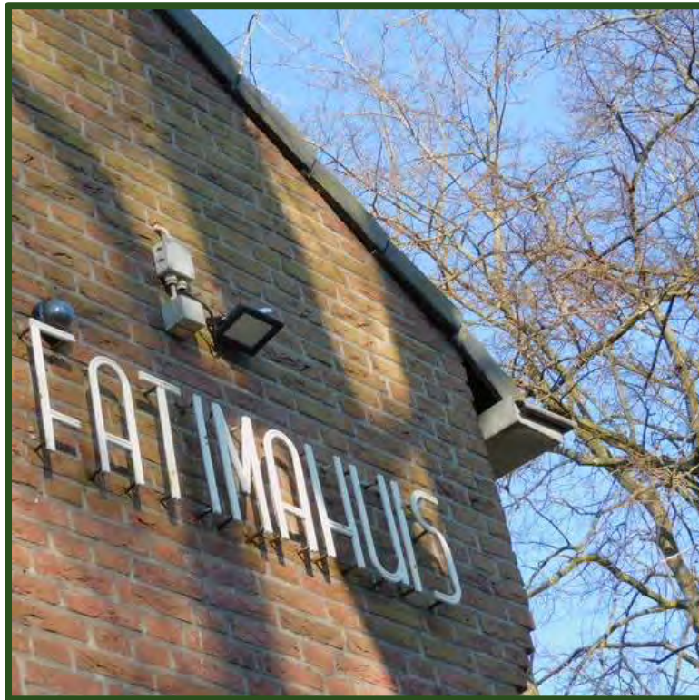
Afbeelding : ruimte tussen de dakpannen en de stenenmuur
