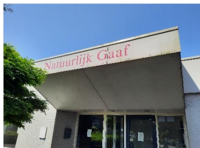
Figuur 2.10 Impressie van de voorgevel gelegen aan de oostzijde van de onderzoekslocatie.
