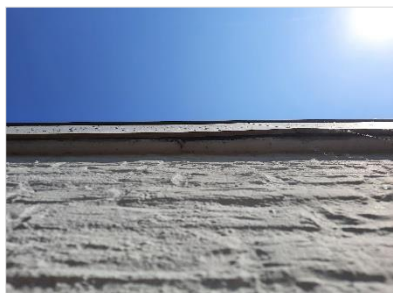
Figuur 2.6 Detailfoto van de gevelbetimmering met een kleine ruimte. Foto met onder aanzicht, genomen aan de zuidzijde van het gebouw.
