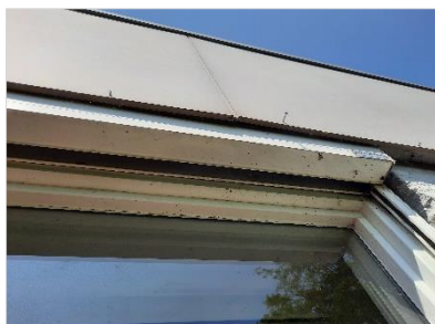
Figuur 2.13 Open ruimte bij gevelbetimmering en raam kozijn met zonnewering.
