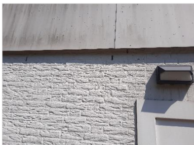
Figuur 2.7 Detailfoto van de open stootvoegen.
