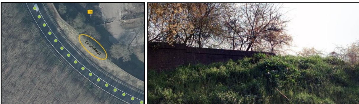
Figuur 8: Locatie grondwal en Overgang kleine panelen op grondwal
