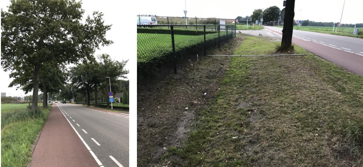
Figuur 28 Foto links: zicht op Wouwbaan in oostelijke richting, foto rechts: impressie groeiplaats bomen in zuidelijke berm.
