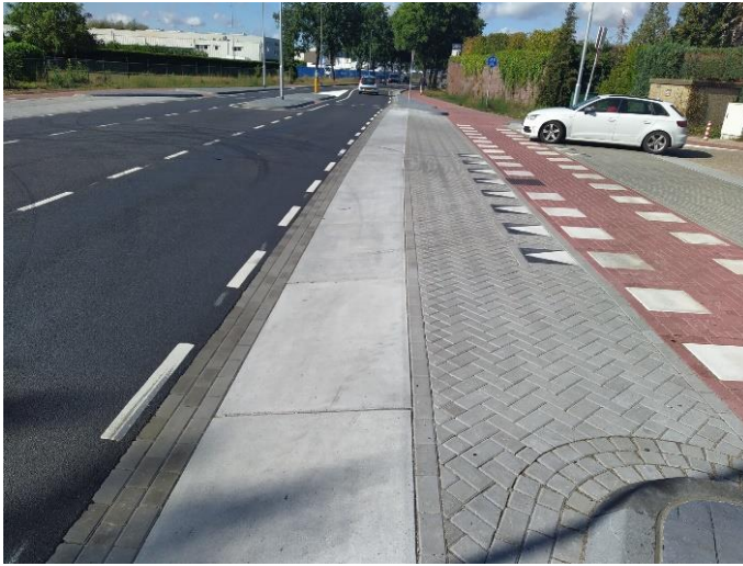
Figuur 2 Voorbeeld van een inritconstructie.
