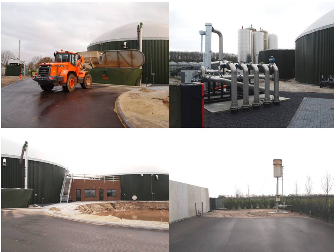
Abbeelding 2.4. Impressie terrein (invoerbak voorvergister, silo's en gasdroger, tussengebouw, fakkel).
