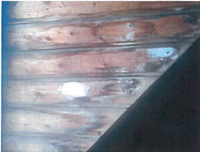
Lekkage raam/dakaansluiting
