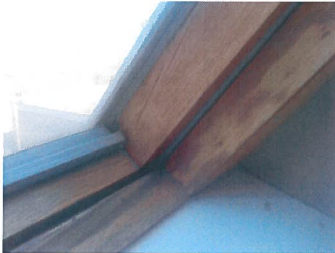
Lekkage raam/dakaansluiting
