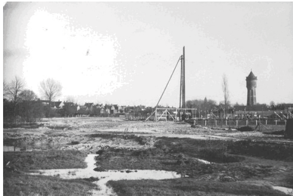
start bouw Nieuwe Markt 1957
