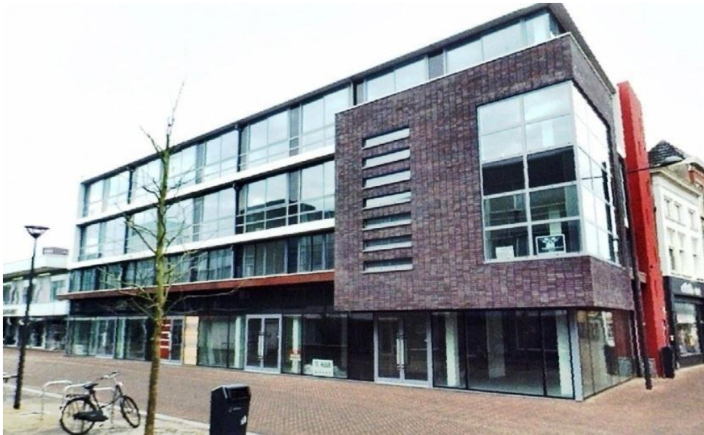
Het inmiddels gerenoveerde hoekpand Dokter Brabersstraat/Markt
