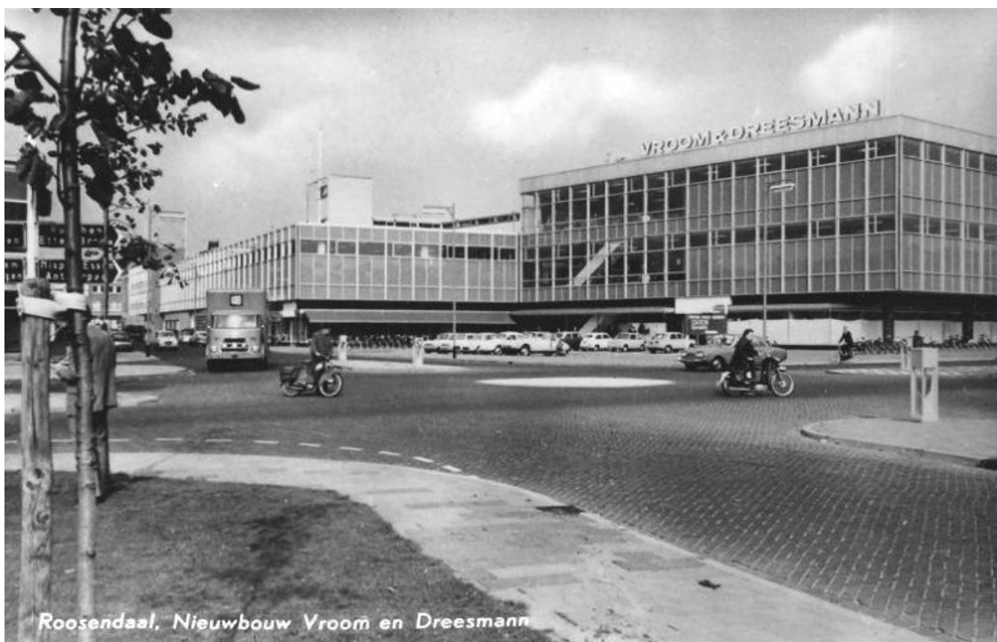
Roosendaal, Nieuwbouw Vroom en Dreesmann Vroom & Dreesmann als entree van het winkelgebied en nog met een rechtstreekse verbinding tussen Burgemeester Freijterslaan en Nieuwe Markt
