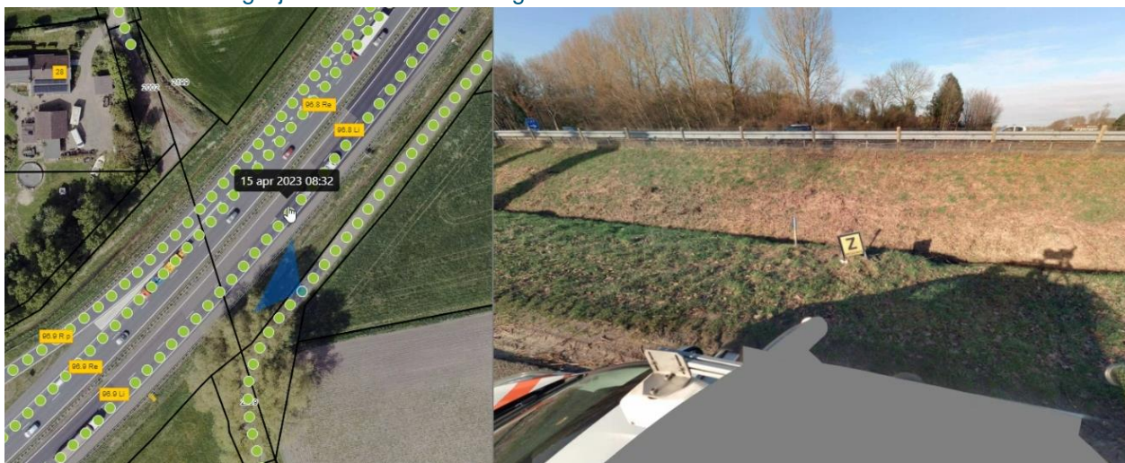
Figuur 10: Locatie zinkerconstructie en toekomstige tunnelconstructie
