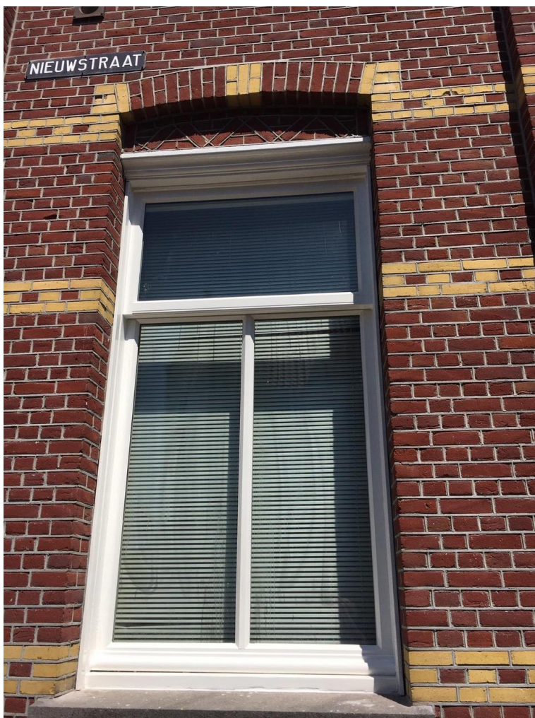
Nieuw kozijn aan de Nieuwstraat
