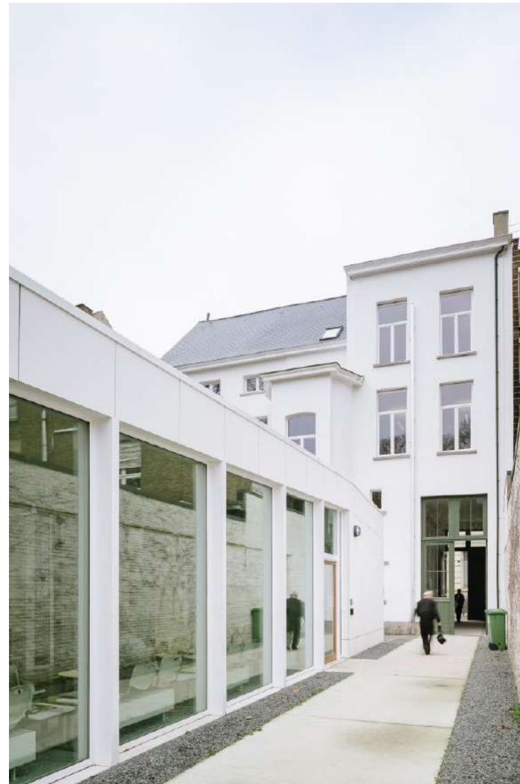
Verbinding tussen 't Groen Kwartier en de Lamorinièrestraat, Antwerpen, MADE Architects
