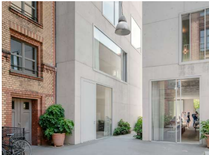
Joachimstrasse, Berlijn - David Chipperfield Architects
