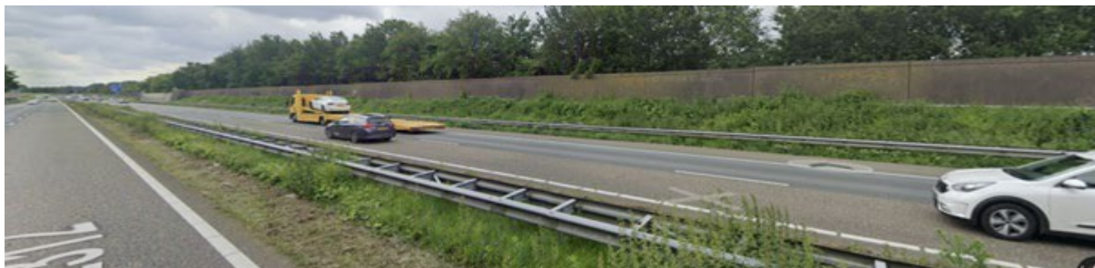
Afbeelding 10. Beeld van de snelweg langs Roosendaal. Onderzocht kan worden of zonnepanelen op de geluidsschermen gemonteerd kunnen worden.
